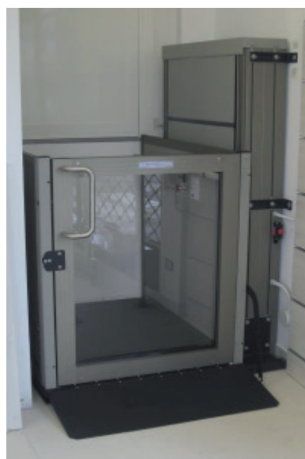
Opal sans fosse avec une rampe pliante
